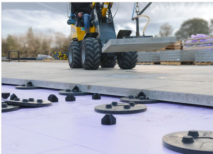
Umkehrdach mit JACKODUR®
