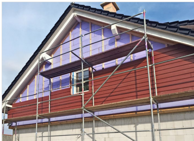
Dämmung hinter Verkleidung mit JACKODUR®
