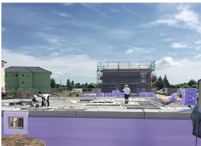
Perimeterdämmung mit JACKODUR®
