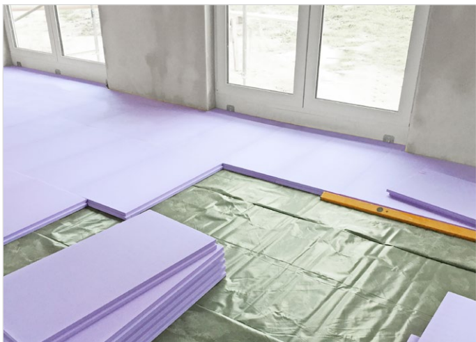
Dämmung unter Industriebestrich mit JACKODUR®
