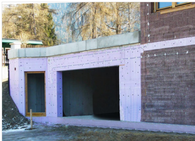
Wärmebrückendämmung mit JACKODUR® Gefiniert
